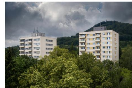
Bytový dům, ul. Kpt. Nálepky, Kopřivnice
