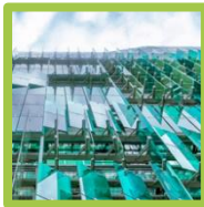
Systémy managementu a MaR budov
