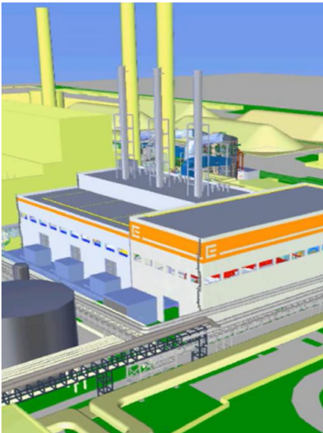
Paroplynový zdroj s možností spalování vodíku
