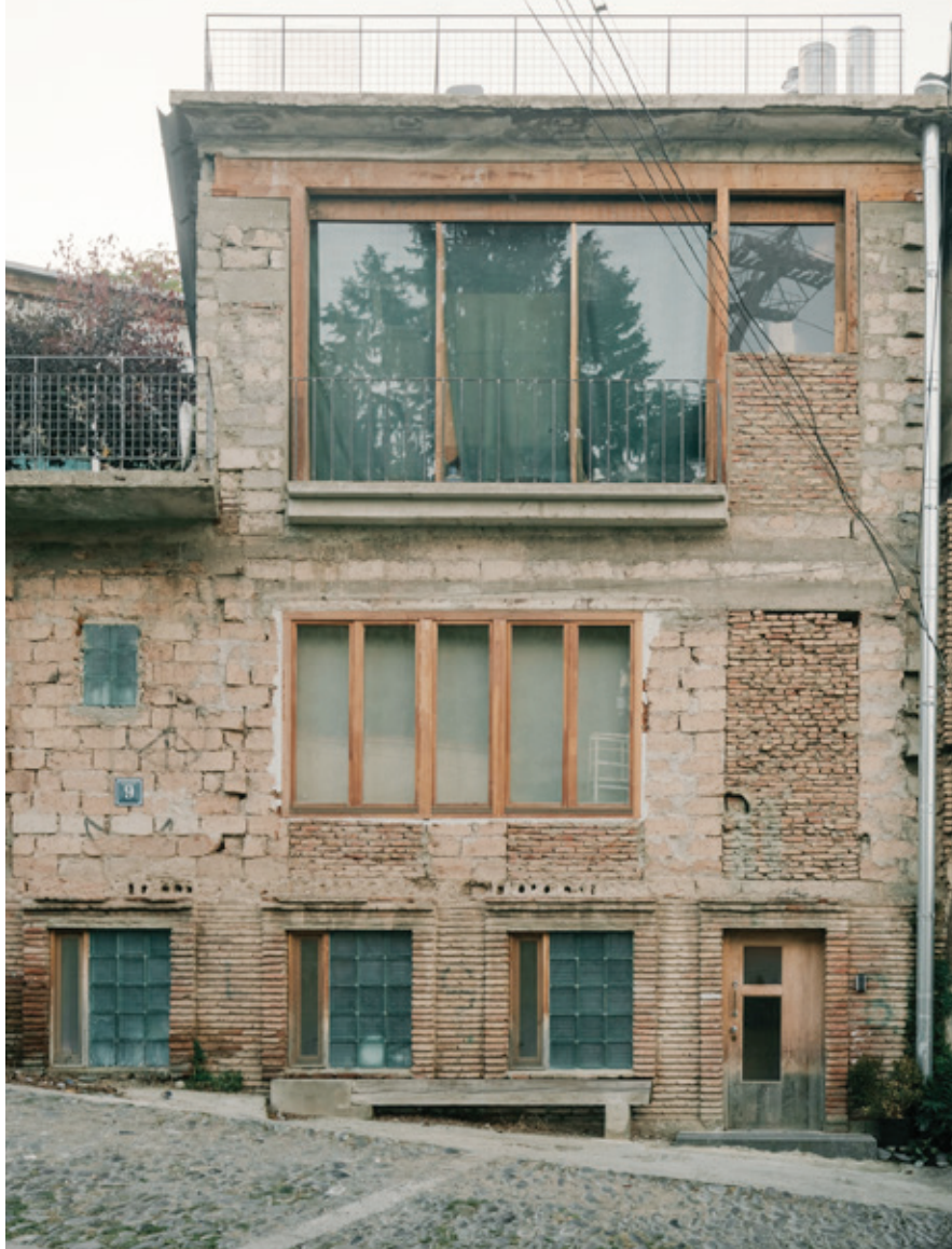
Nedokončený dům v Tbilisi, Gruzie. Architekti Alexander Brodsky a David Brodsky, 2026. Foto: Grigory Sokolinsky.
