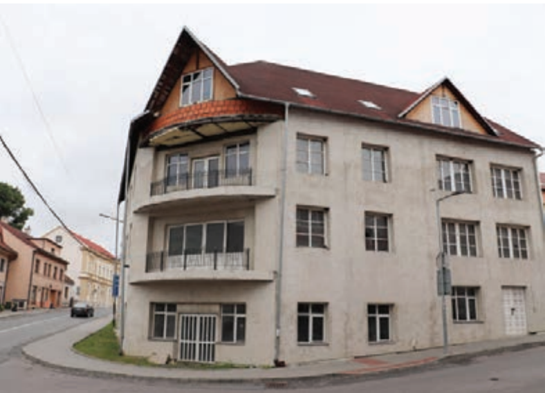
Valašské Klobouky – stav před revitalizací
