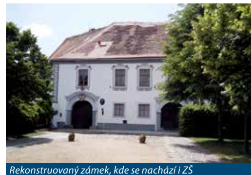
Rekonstruovaný zámek, kde se nachází i ZŠ
