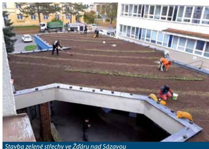
Stavba zelené střechy ve Žďáru nad Sázavou
