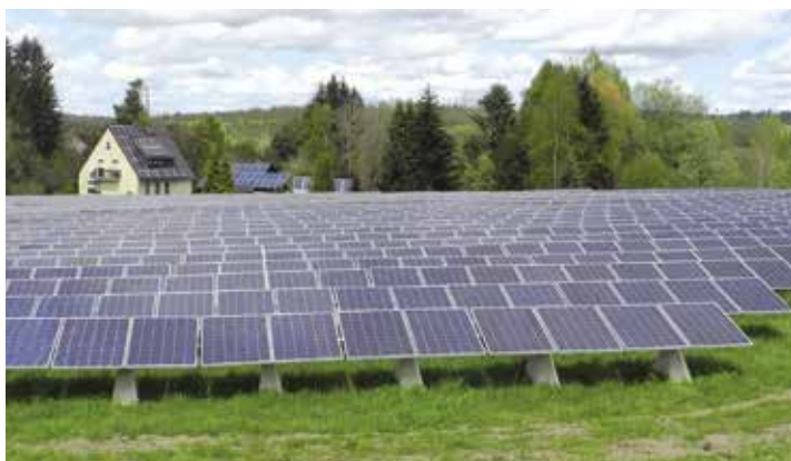
Rekultivovaná skládka v Schöwaldu (SRN) s instalovaným výkonem 668 kW na rozloze 3 hektarů. Spuštění elektrárny se uskutečnilo v lednu 2019 a vzbudilo velký ohlas mezi starosty dalších obcí, kteří mají o podobná řešení zájem. V Německu se na elektrárny na brownfieldech pohlíží jako na střešní instalace, což usnadňuje jejich realizaci i připojení do sítě.
