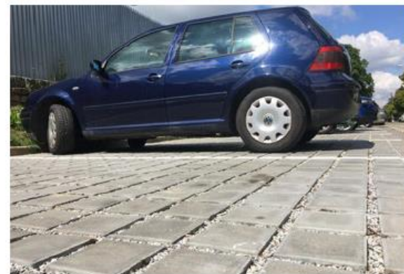
↑ Betonová dlažba se širokou šterkovou spárou, parkoviště Jihlava, zdroj: foto autor
