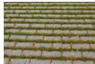
↑ Zatravněná betonová dlažba, Remier Park, Mnichov, zdroj: foto autor
