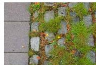
↑ Dlažba se suchomilnými nízkými rostlinami, areál banky Swiss Re, Mnichov, zdroj: foto autor
