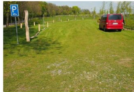
↑ Štěrkový trávník na parkovišti, hřbitov Dolní Břežany, zdroj: foto autor
